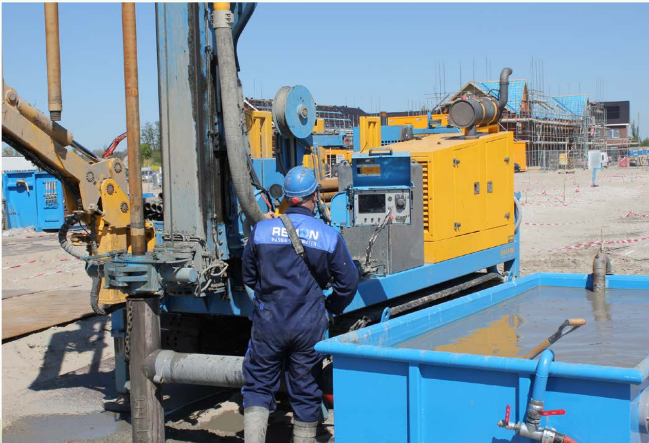
Bodemboring in een nieuwbouwwijk in Gouda, waar volledige woonwijken worden voorzien van bodemenergie
