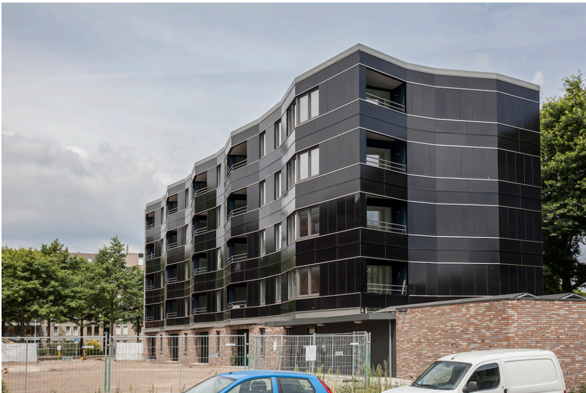
Zonnepanelen als gevelbekleding – bron: NBArchitecten (Best)
