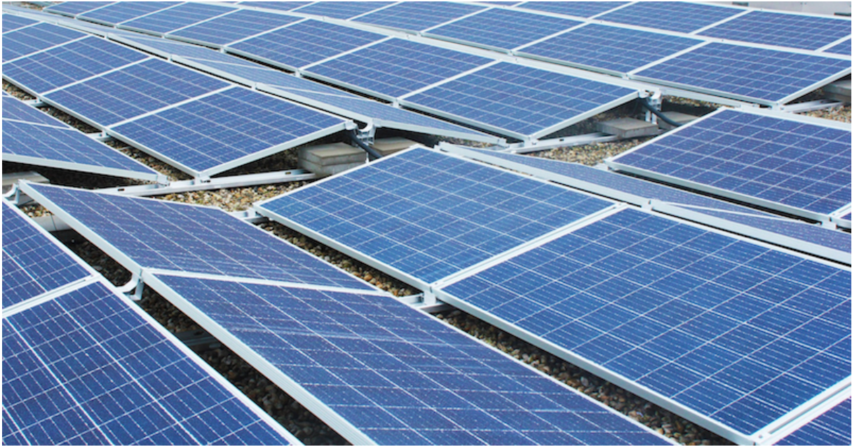
Zonnepanelen met oost-west oriëntatie – bron: NP RES
