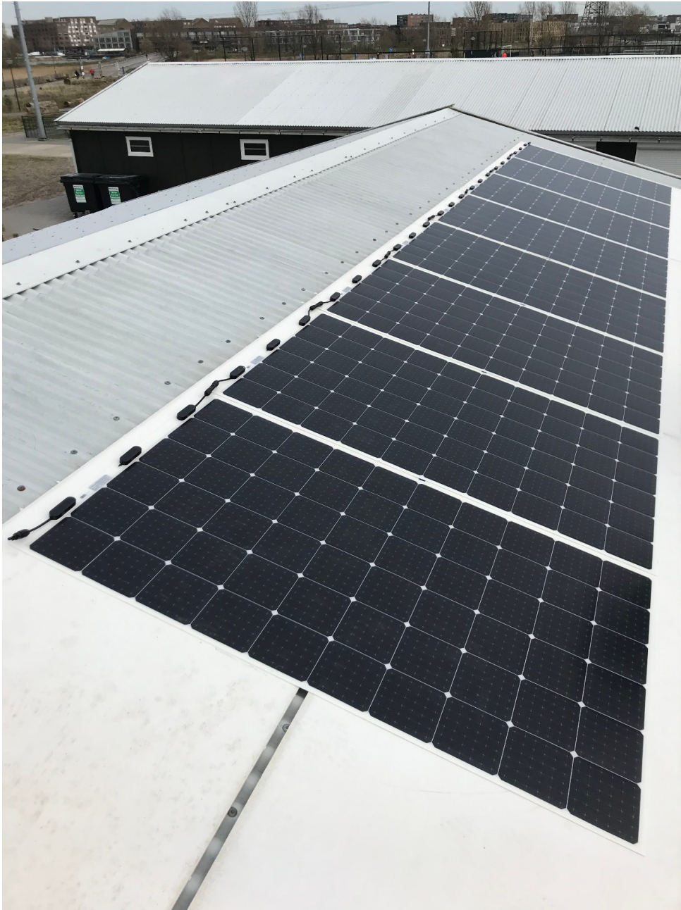
Lichtgewicht zonnepanelen – bron: Stiels B.V.
